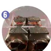
**6** Banco de Baterías: El sistema de incendio va acompañado de baterías con opciones, 02x o 04x baterías de 12 o 24 Volts dependiendo de cada sistema y/o motor.
